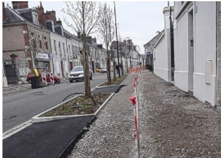
Du 25 au 31 mars, l'étape des finitions pour les pistes cyclables, les trottoirs, la bande de roulement, les places de stationnement. (Photo, mairie de Mer)
